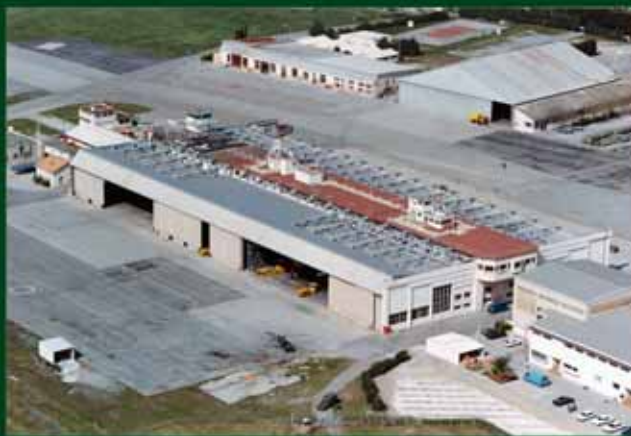
- Hangars à avions à Fréjus (1936), à Lyon-Bron (1928) et à Bricy
